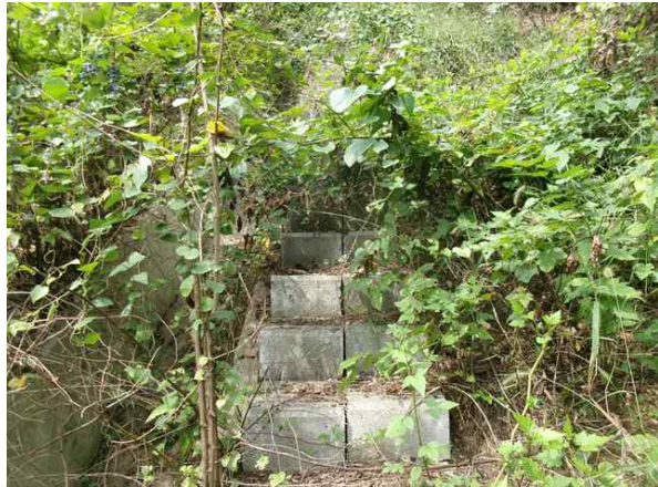
산마루측구, 점검계단 전경
