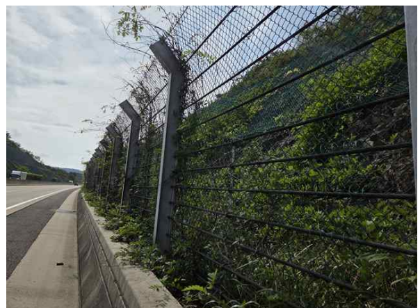
도로, 낙석방지울타리 전경
