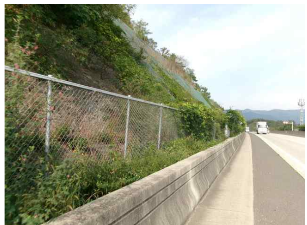
야생동물유도울타리, 도로부 전경
