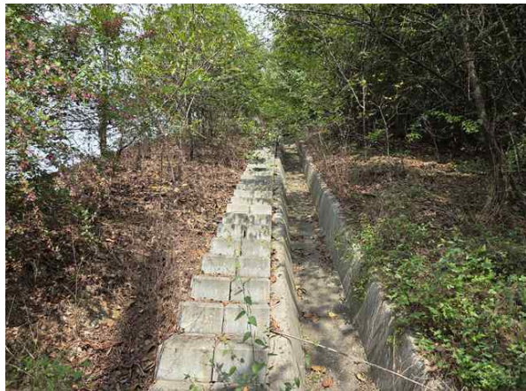
산마루측구, 점검계단 전경
