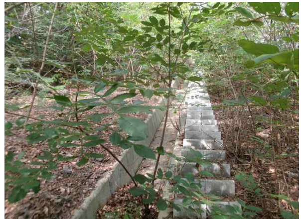
산마루측구, 점검계단 전경
