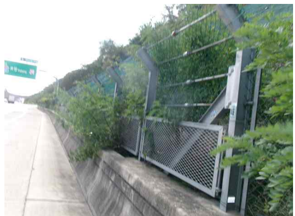
도로, 낙석방지울타리 전경
