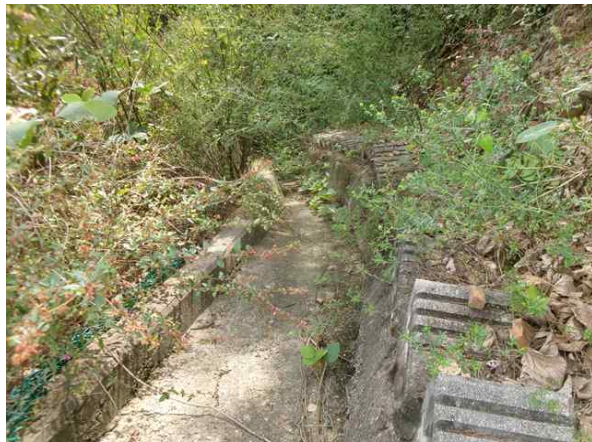
산마루측구, 점검계단 전경
