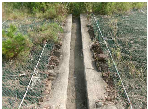
숏크리트, 점검계단 전경
