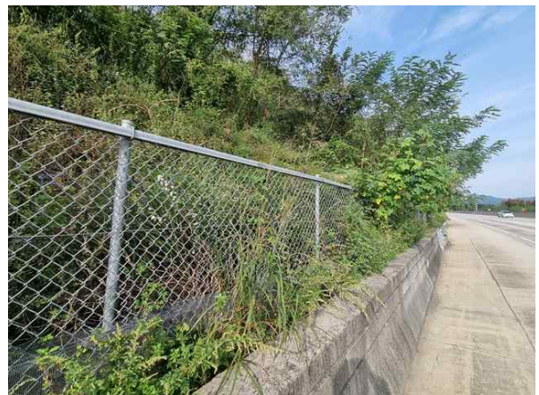
하부 야생동물유도울타리 전경
