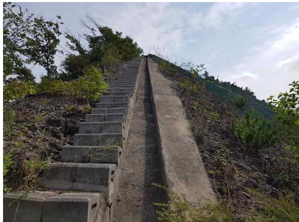
산마루측구, 점검계단 전경
